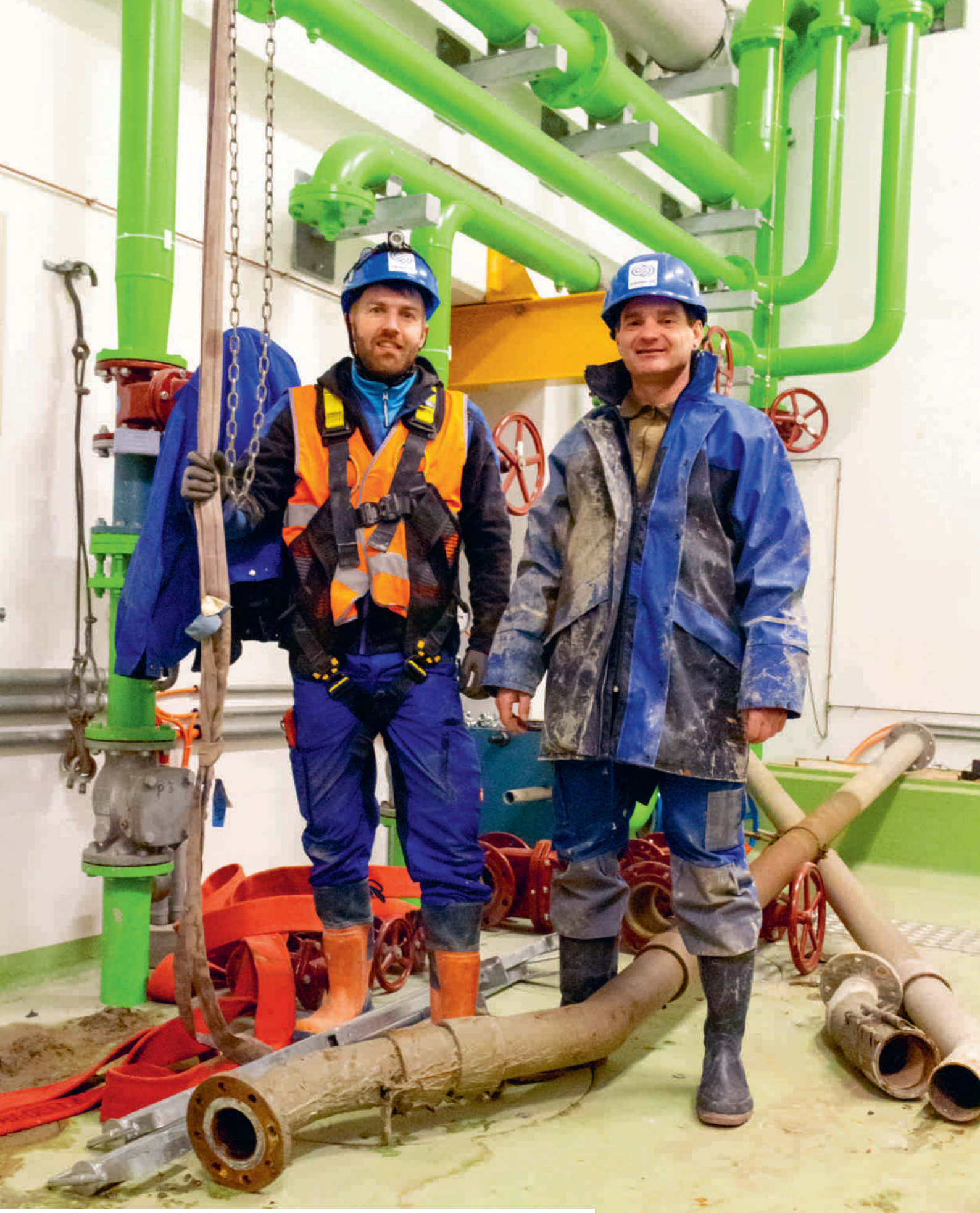
Der Ausbau der alten Kühlwasserleitungen war schmutzintensiv.
