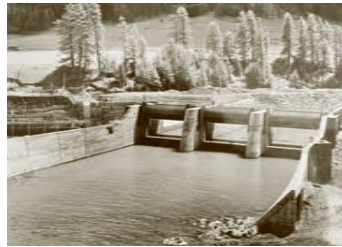
S-chanf, Wehr im Bau, Juni 1968
