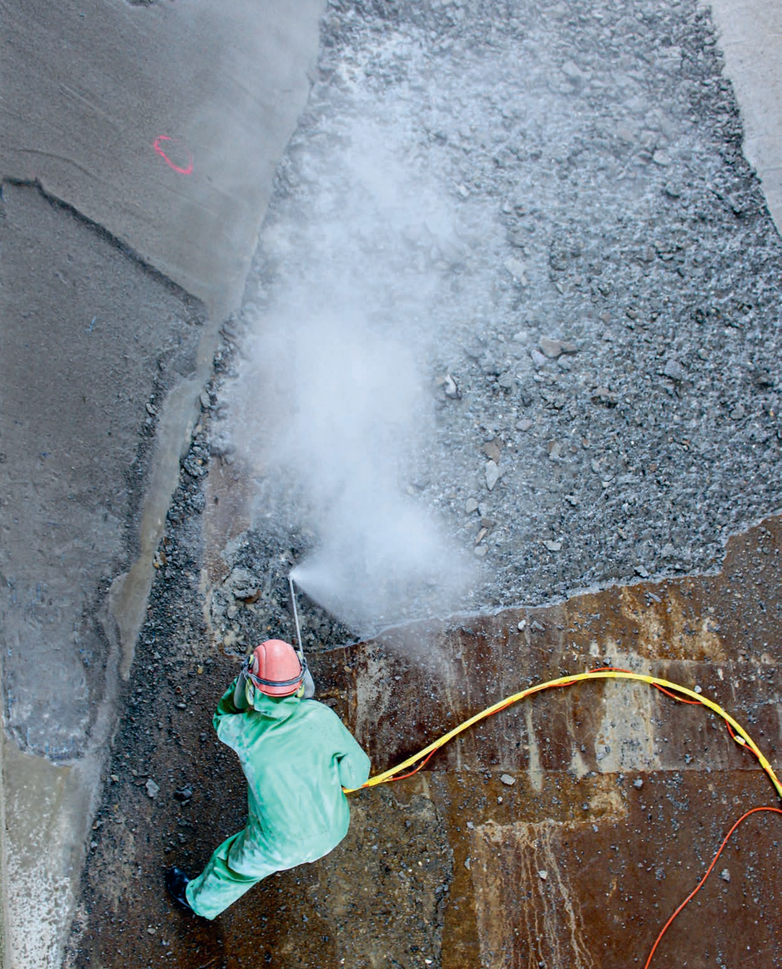
Arbeit unter Höchstdruck: Mit 2'500 bar schießt der Wasserstrahl aus dem Schlauch und entfernt den alten Überzug bei den Entsanderbecken der Wasserfassung S-chanf.
