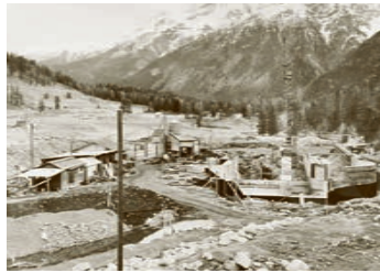
Vallember, im Bau, Nov. 1968
