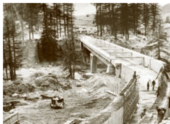
S-chanf, Freispiegelstollen, Nov. 1968
